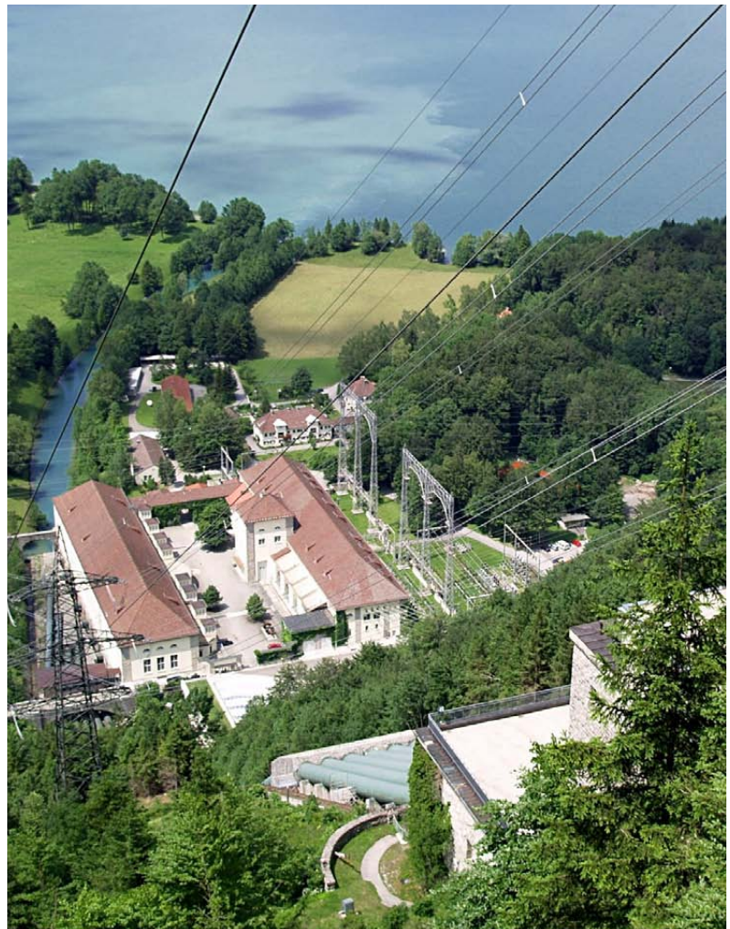
Walchenseekraftwerk Kochel am See, Bayern
